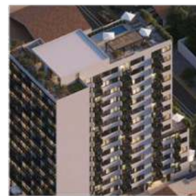
Ventilación y vistas de Norte, Sur, Este y Oeste
